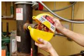
**CIERRES PARA VÁLVULA DE COMPUERTA**
